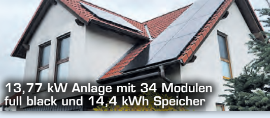
13,77 kW Anlage mit 34 Modulen full black und 14,4 kWh Speicher
