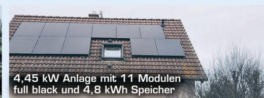
4,45 kW Anlage mit 11 Modulen full black und 4,8 kWh Speicher
