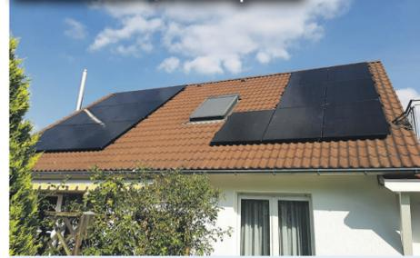
6,15 kW Anlage mit 15 Modulen und 4,8 kWh Speicher
