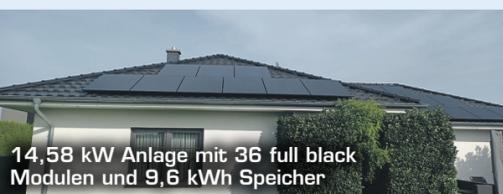
14,58 kW Anlage mit 36 full black Modulen und 9,6 kWh Speicher
