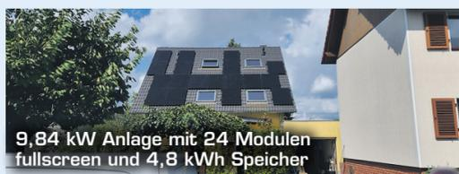
9,84 kW Anlage mit 24 Modulen fullscreen und 4,8 kWh Speicher
