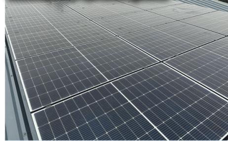
12,3 kW Anlage mit 30 Modulen fullscreen und 9,6 kWh Speicher
