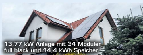
13,77 kW Anlage mit 34 Modulen full black und 14,4 kWh Speicher
